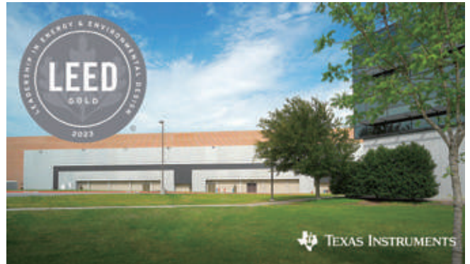
▲ 텍사스 인스트루먼트의 RFAB2 반도체 제조 공장은 고성능 친환경 건물의 지속가능한 설계, 건설 및 운영을 인정받아 미국 그린빌딩협회(USGBC)로부터 LEED 골드 인증을 획득했다.
