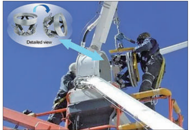
▲ ALMA 전파 망원경 어레이 중 하나에 설치되는 천문학 시스템을 위한 방수 정밀 헥사포드. 헥사포드는 감도를 향상시키기 위해 50개의 망원경의 서브 리플렉터를 정렬한다. ALMA 망원경 어레이는 2017년 블랙홀의 첫 촬영에서 필수적이었다.
